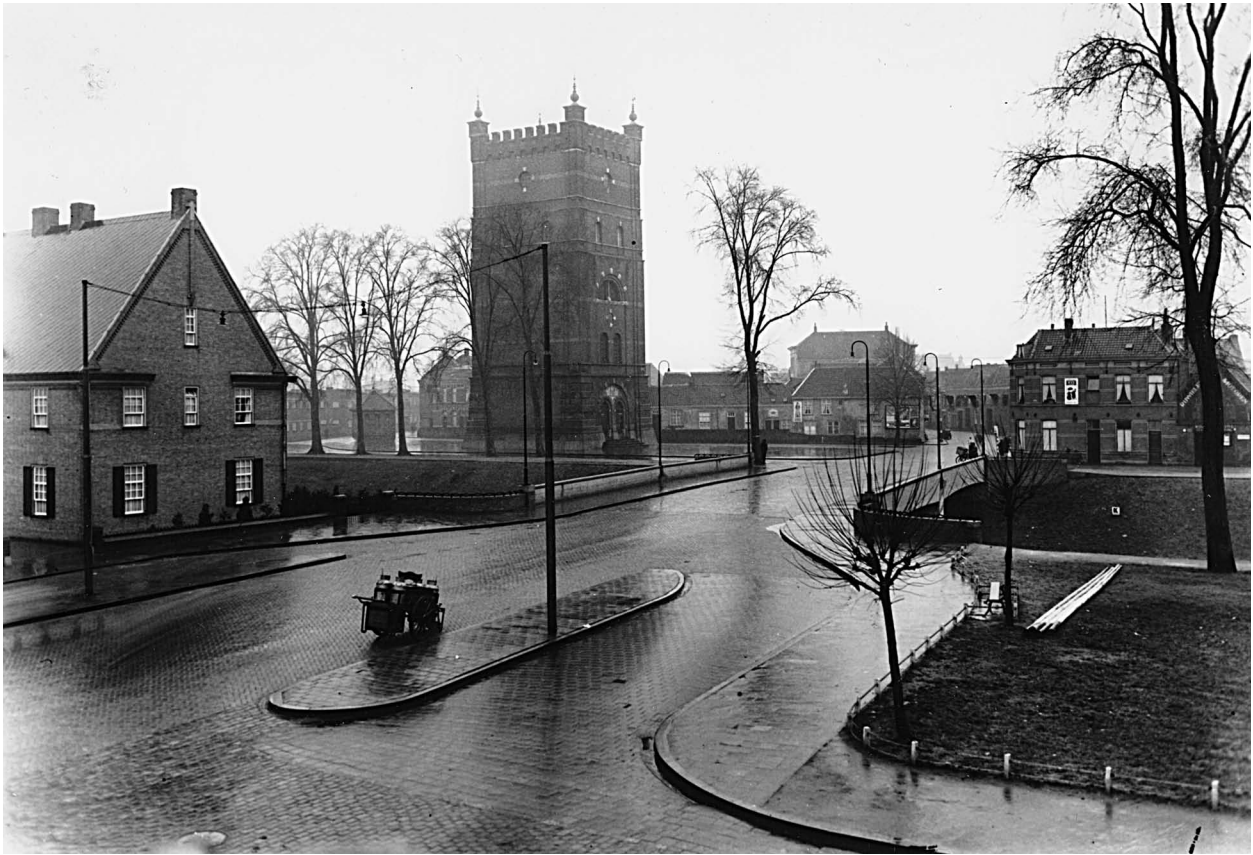
Links de pastorie van de (verdwenen) 'Bartjeskerk', in het midden de watertoren en rechts de Aawal. Een foto uit 1937. (Foto: Stadsarchief, collectie Het Zuiden)
