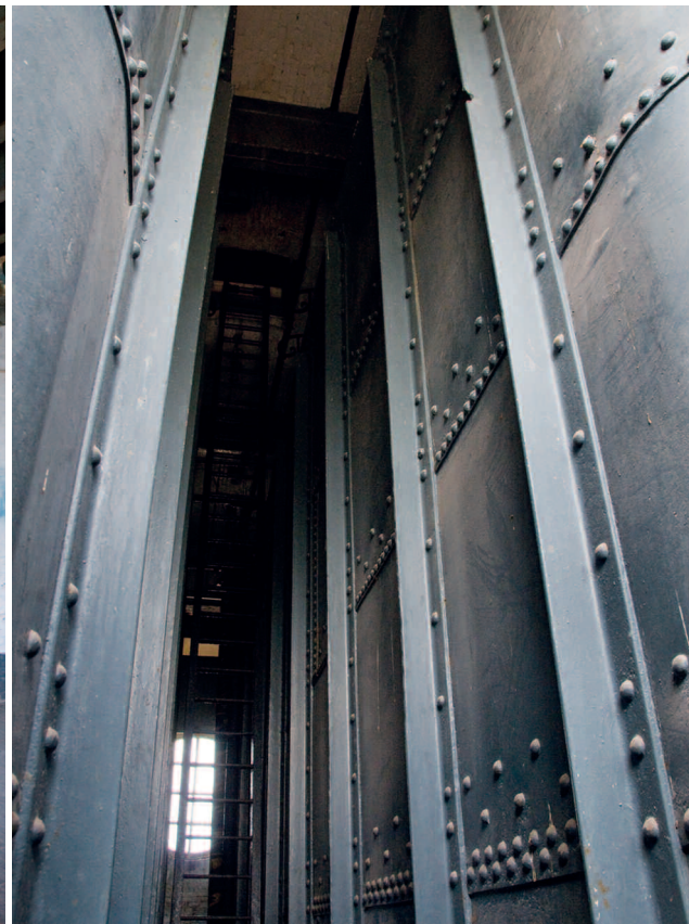
De twee identieke rechthoekige vlakbodem-reservoirs van geklonken plaatijzer met een gezamenlijke capaciteit van 400 kubieke meter. (Foto: Olaf Smit, 2009)
