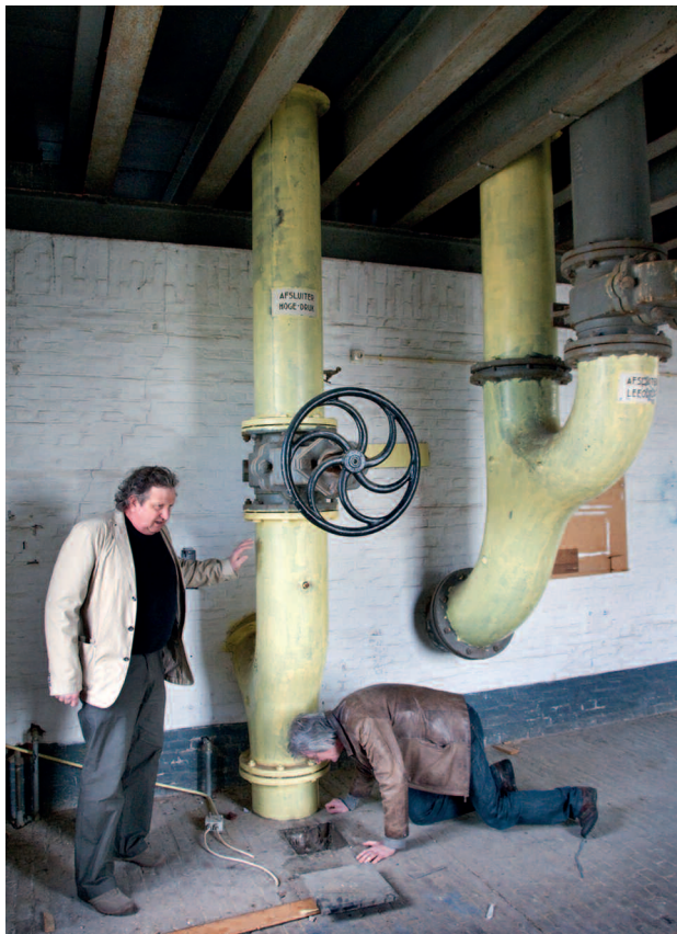
Harry Boekwijt (links) en Jan Moerbeek inspecteren de technische voorzieningen op de vijfde verdieping. (Foto: Olaf Smit, 2009)
